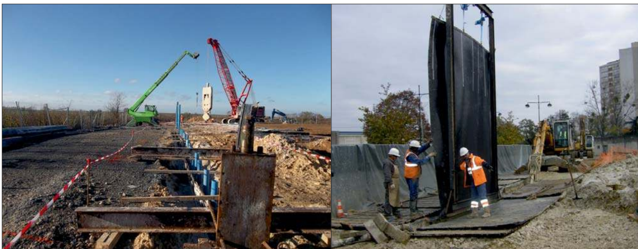
Ryc. 7. Bariery nieprzepuszczalne. Fot. Arch. Menard
