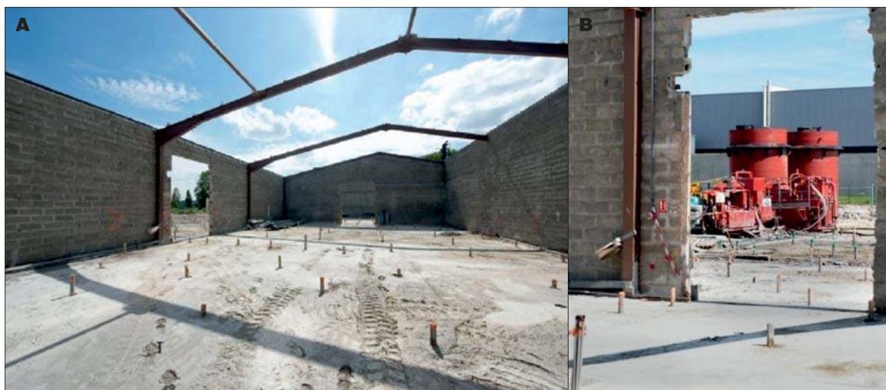
Ryc. 3. Metoda stabilizacji; A – siatka punktów iniekcyjnych; B – jednostka produkująca reagent. Fot. Arch. Menard Fig. 3. Stabilization method; A – grid of injection points; B – reagent production unit. Photo Menard Archieve
