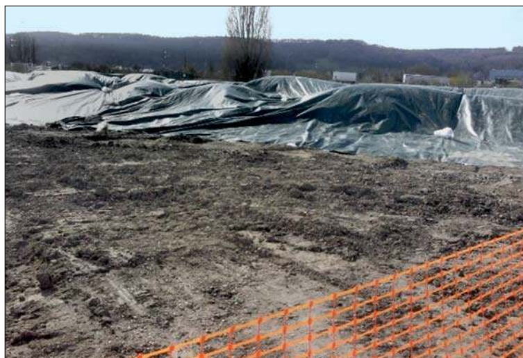
Ryc. 4. Bioremediacja zanieczyszczonego gruntu na poletkach bioremediacyjnych. Fot. Arch. Menard Fig. 4. Bioremediation of contaminated soil in bioremediation plots. Photo Menard Archive
