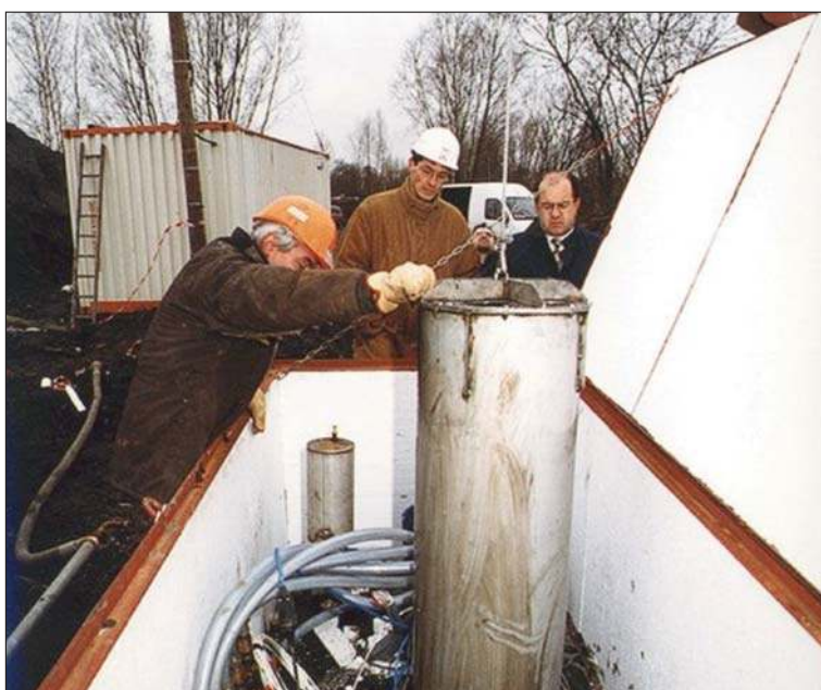
Ryc. 9. Przepuszczalna bariera reaktywna wypełniona żelazem zerowartościowym. Fot. Arch. Menard Fig. 9. The permeable reactive barrier filled with iron. Photo Menard Archive
