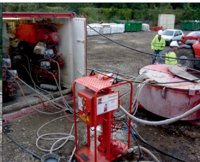
Ryc. 5. Wprowadzenie iniektu Fig. 5. Introduction of injection
