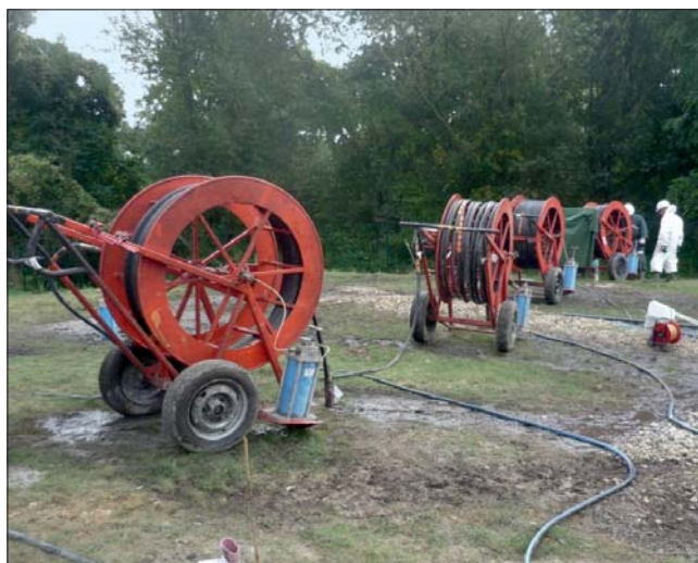
Ryc. 6. Wprowadzanie iniektu do studni. Fot. Archiwum Menard Fig. 6. Insertion of injection into wells. Photo Archiwum Menard
